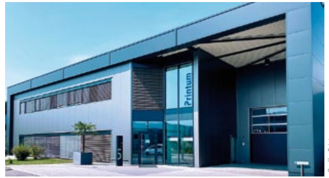
Blick auf die Produktionsstätte der Printum Technology GmbH in Ravensburg
